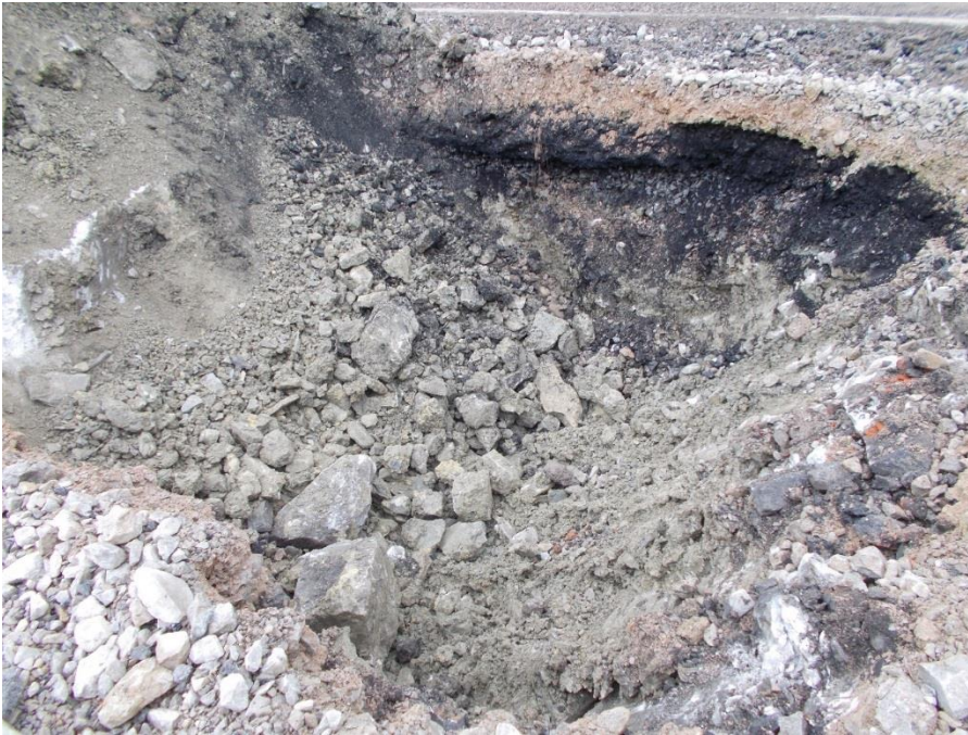
Abbildung 1 Baggereschurf im Bereich der Verdachtsfläche 7060-04-003-10
