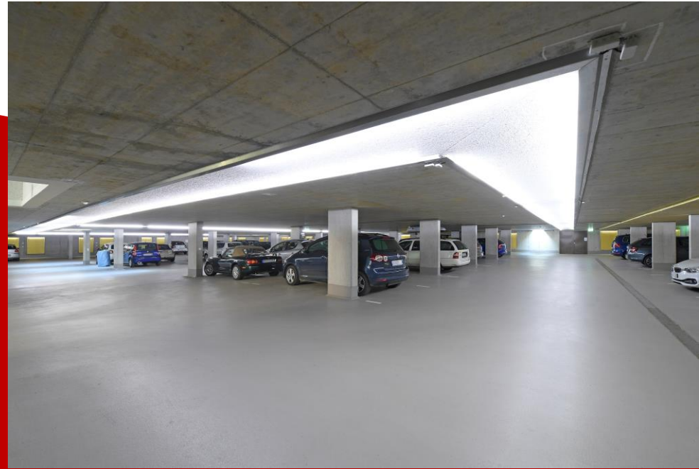
gemeinschaftliche Tiefgarage Hof 1, Alte Weberei in Tübingen, Architektur Baisch + Fritz Architekten, Foto G. De Maddalena
