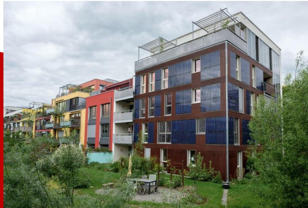
Baugemeinschaftsprojekt "Null-Energie-Haus elementar", Mühlenviertel Tübingen, Foto M. Smyrek
