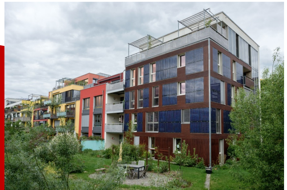
Null-Energie-Haus "elementar" Tübingen, Foto M. Smyrek
