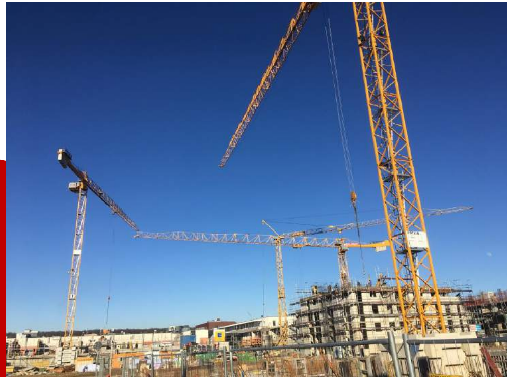
Kräne im Steingauquartier in Kirchheim unter Teck, Foto T. Gauggel
