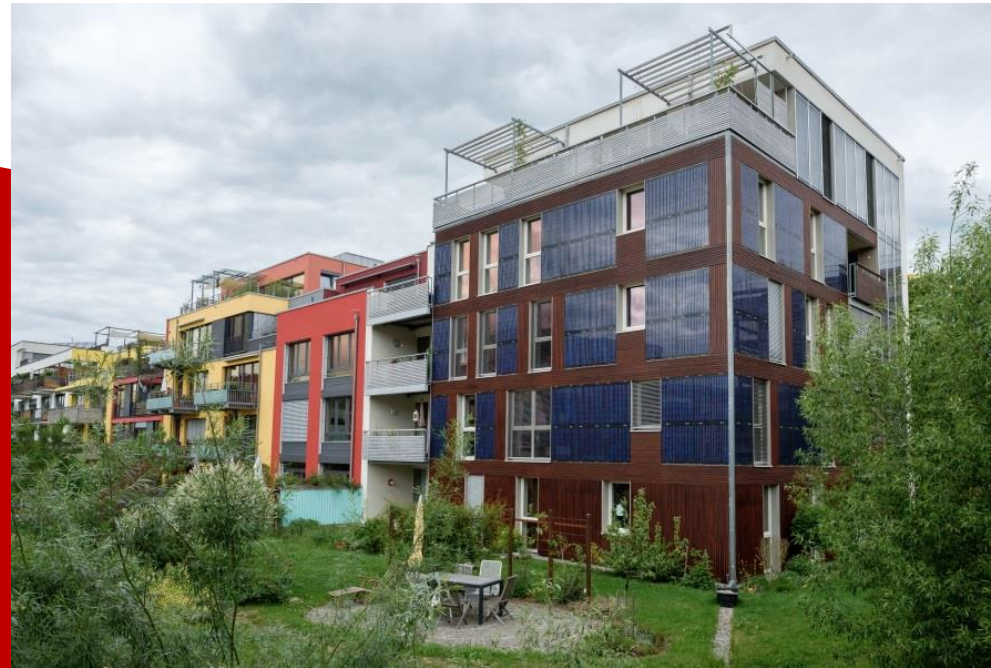
Baugemeinschaft Null-Energie-Haus „elementar“, Mühlenviertel in Tübingen, Foto M. Smyrek
